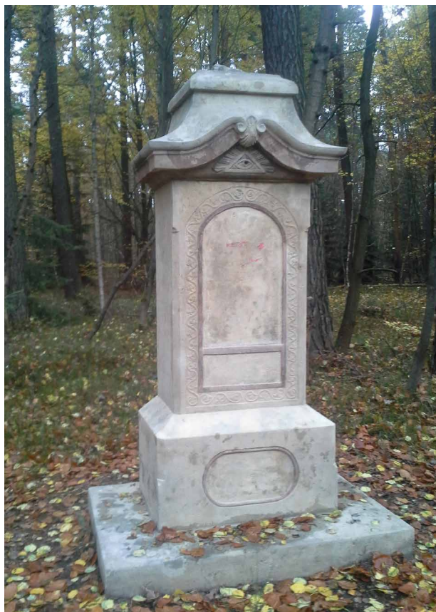
Obr. 8. Kuřívody (okr. Česká Lípa), křížek restaurovaný v roce 2016, D. Janouch.
