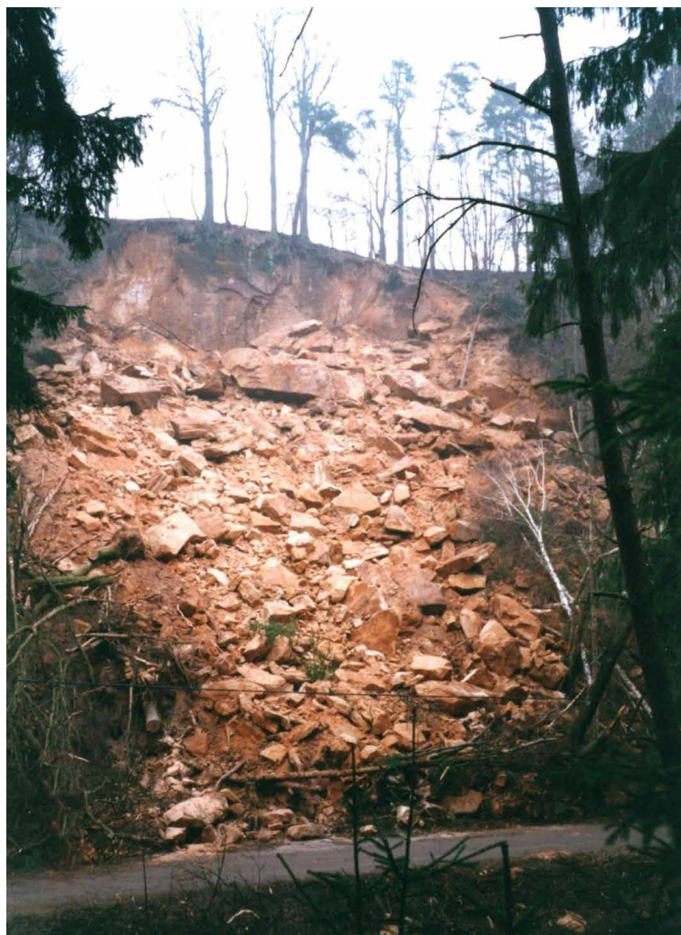
Obr. 1. Celkový pohled. Foto archiv autora, 5. 3. 1999.
