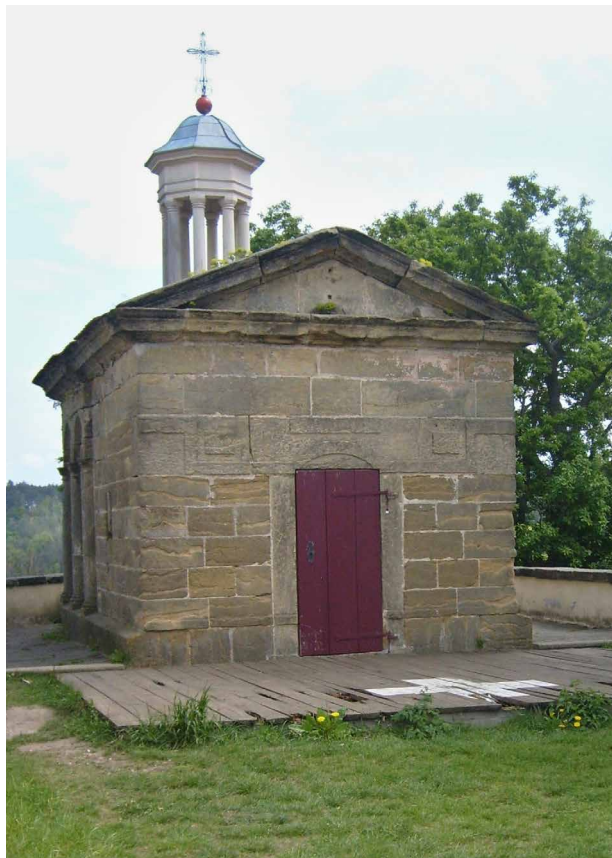
Obr. 1. Ostré (okr. Litoměřice), vybudování nové lucerny kaple Božího hrobu, 2013, D. Janouch, J. Šmídek, J. Kalina, O. Škach.
