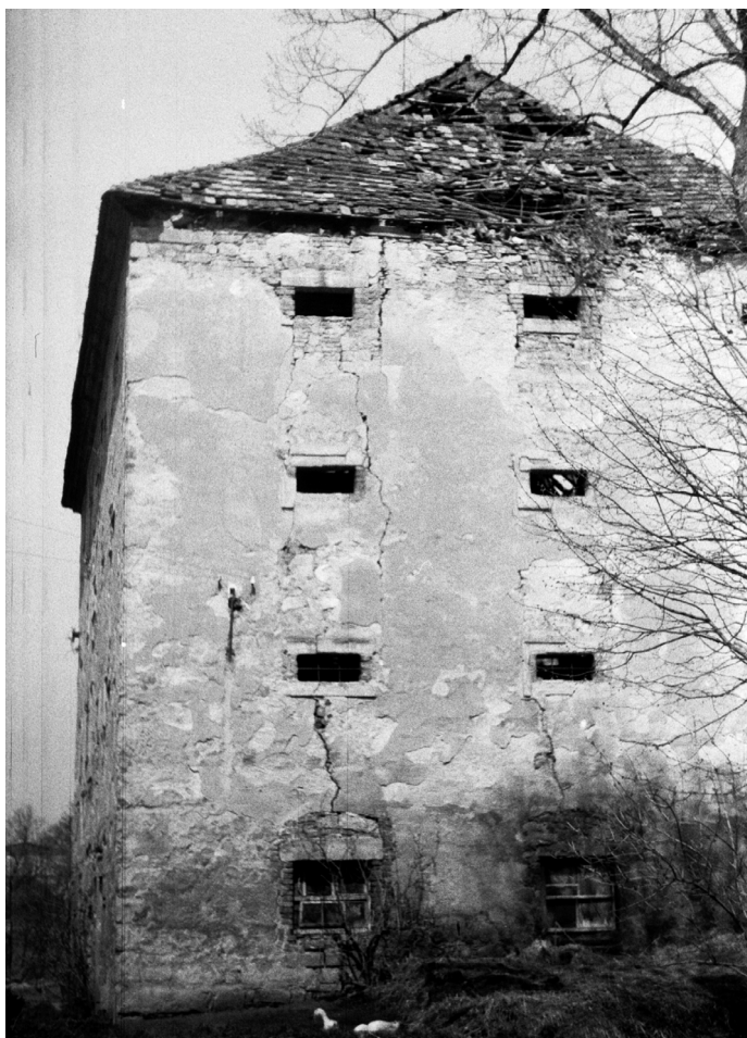
Obr. 5. Tlustec (okr. Česká Lípa), jižní průčelí tvrze. Dobře patrná jsou upravená okna v přízemí a obdélná ležatá okénka sýpky v patrech. Stav 20. dubna 1985.
