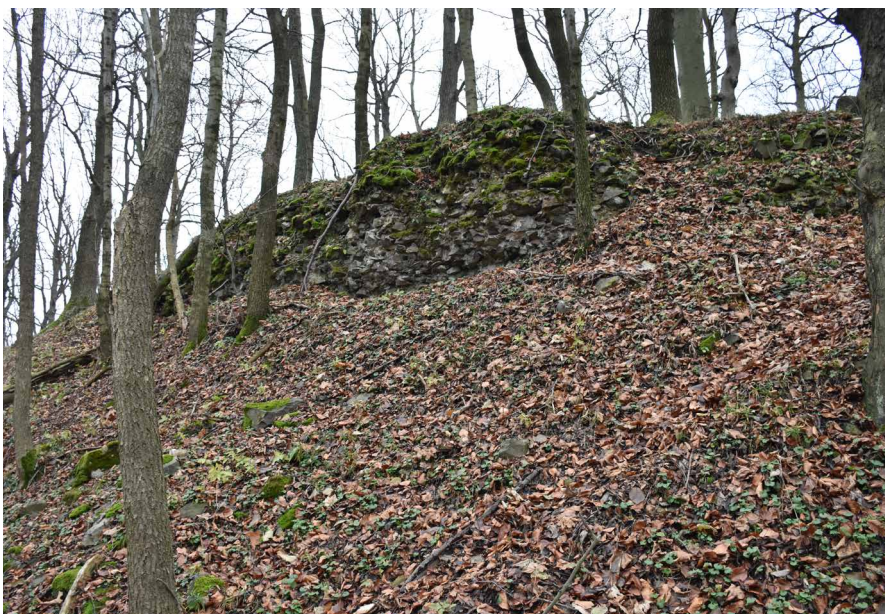
Obr. 11. Falkenburk (okr. Česká Lípa), zbytek obvodové hradební zdi v severozápadní části hradu (stav 23. listopadu 2019; foto autor).
