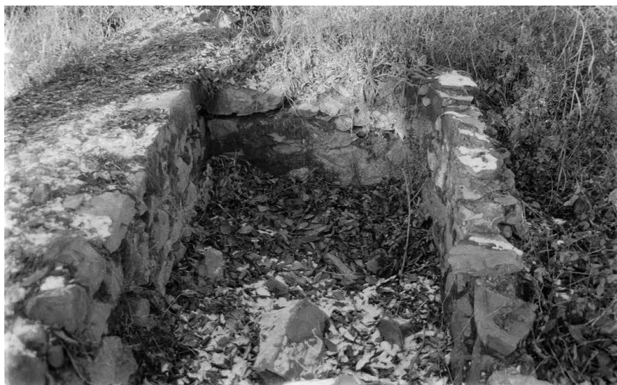
Obr. 8. Falkenburk (okr. Česká Lípa), zbytek zdiva neznámého účelu, dodatečně přizdžený k vnitřní lici západní obvodové zdi obytné budovy (stav 28. října 1997; foto autor).
