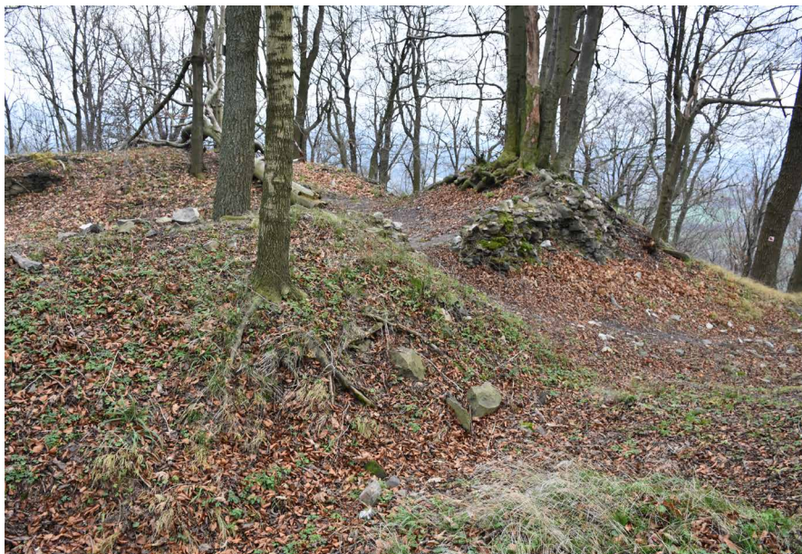
Obr. 13. Falkenburk (okr. Česká Lípa), zbytky zdiva jihozápadního nároží obytné budovy (stav 23. listopadu 2019; foto autor).
