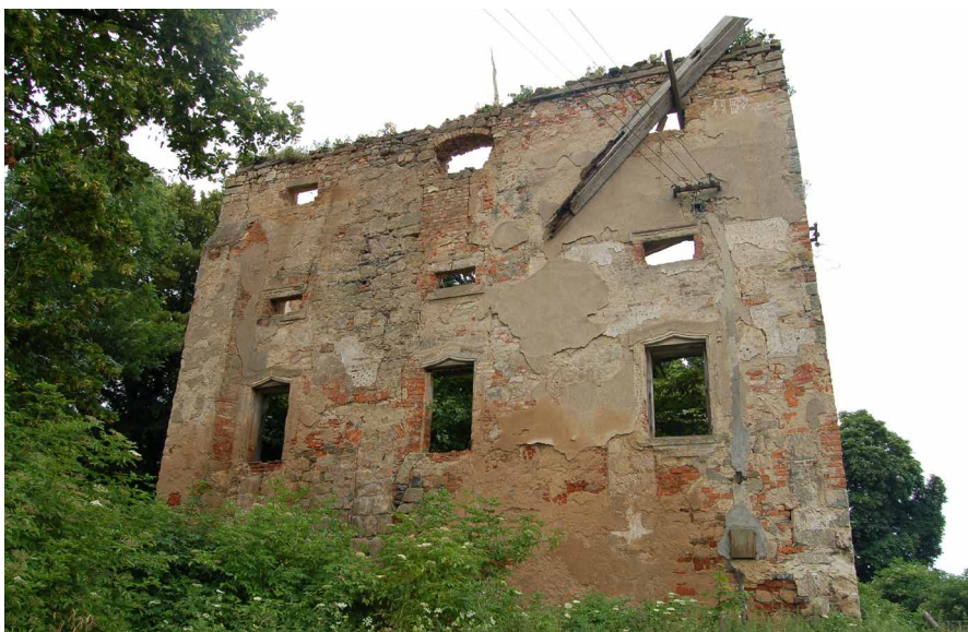
Obr. 8. Tlustec (okr. Česká Lípa), severní průčelí tvrze, které bylo přistavěno ke starší budově. Stav 27. června 2009.
