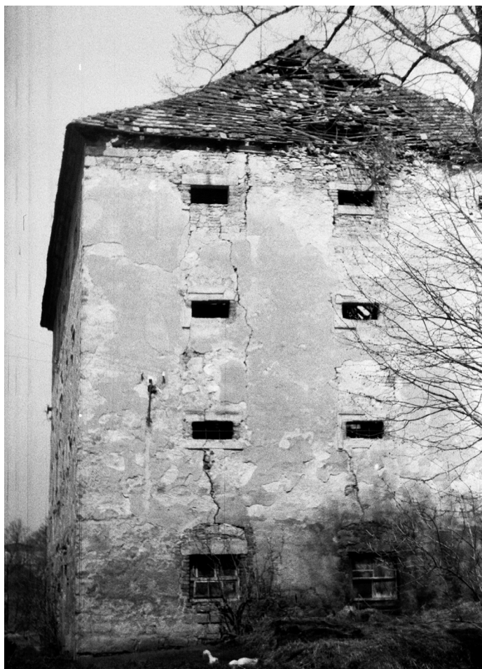
Obr. 5. Tlustec (okr. Česká Lípa), jižní průčelí tvrze. Dobře patrná jsou upravená okna v přízemí a obdélná ležatá okénka sýpky v patrech. Stav 20. dubna 1985.
